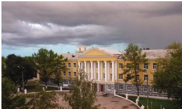
Балахнинский политехнический колледж.
