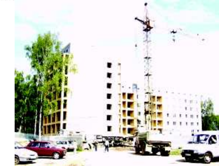
Заканчивается строительство одного из домов программы «Доступное жилье».
