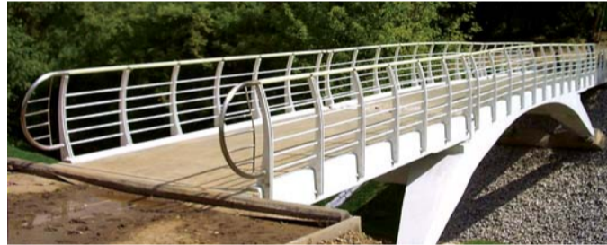
Пешеходные мосты конвейерного производства из углекомпозитного материала. Время установки моста — 2 часа.
